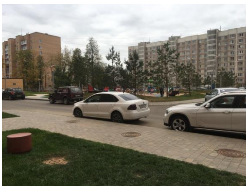
Фото 9 Внешний вид и прилегающая территория к жилому дому, расположенного по адресу: Московская обл., г. Чехов, Чеховский р-н, ул. Лопасненская, д. 5
