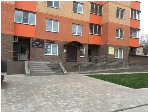
Фото 17 Внешний вид и прилегающая территория к жилому дому, расположенного по адресу: Московская обл., г. Чехов, Чеховский р-н, ул. Лопасненская, д. 7
