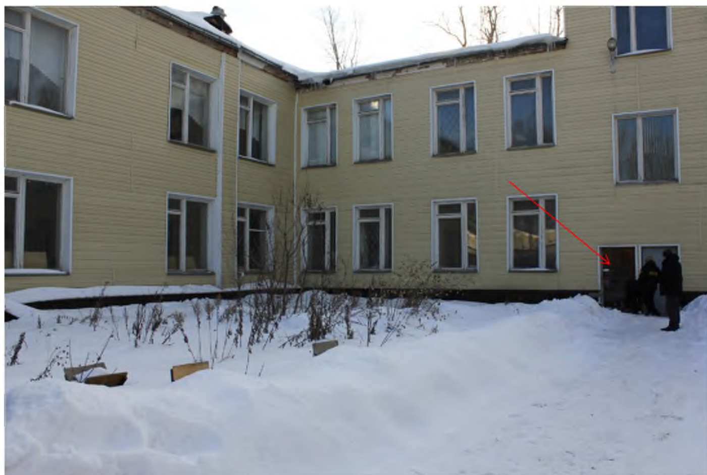
Фото 1.9 Вход в подвал снаружи здания
