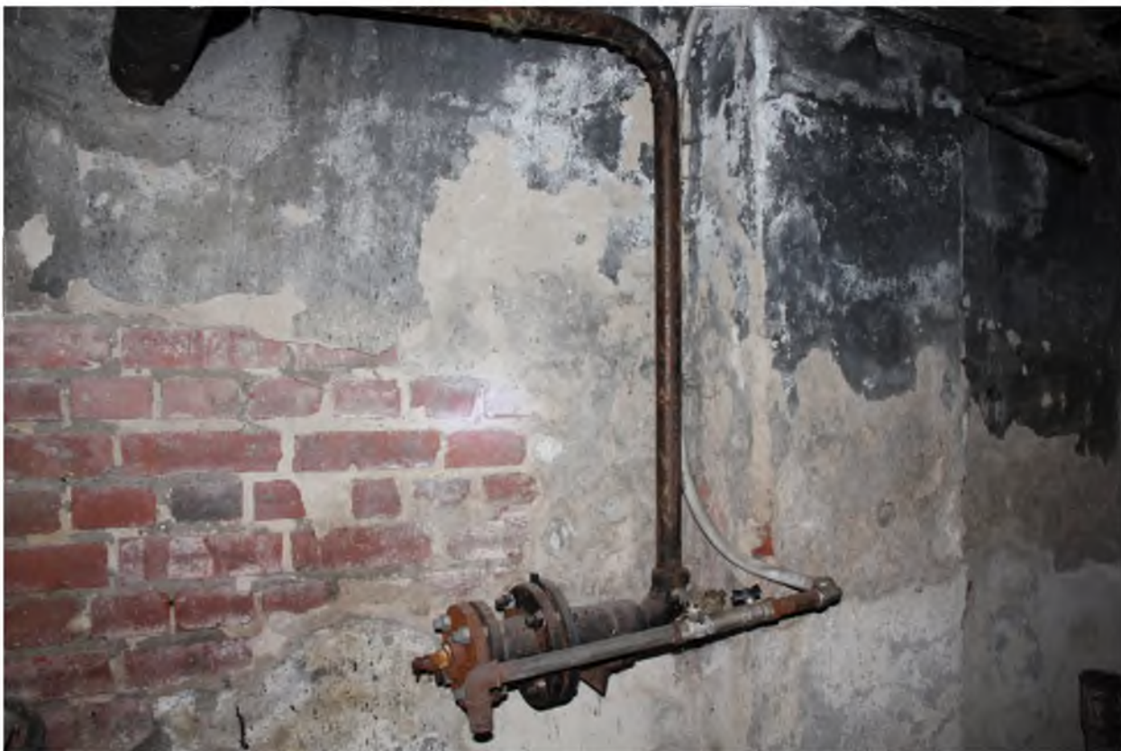
Фото 4.5 Отключение потребителей здания от водоснабжения
