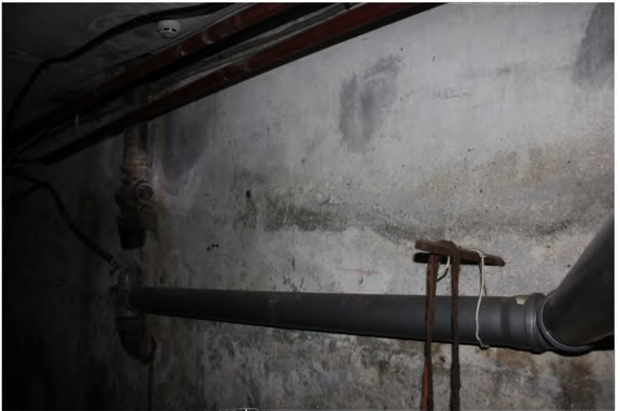
Фото 4.11 Крепление трубы водостока.
