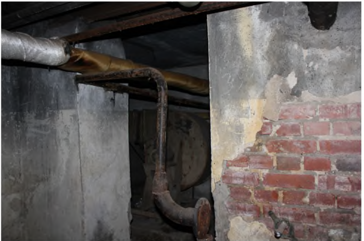
Фото 4.4 Отключение потребителей здания от водоснабжения
