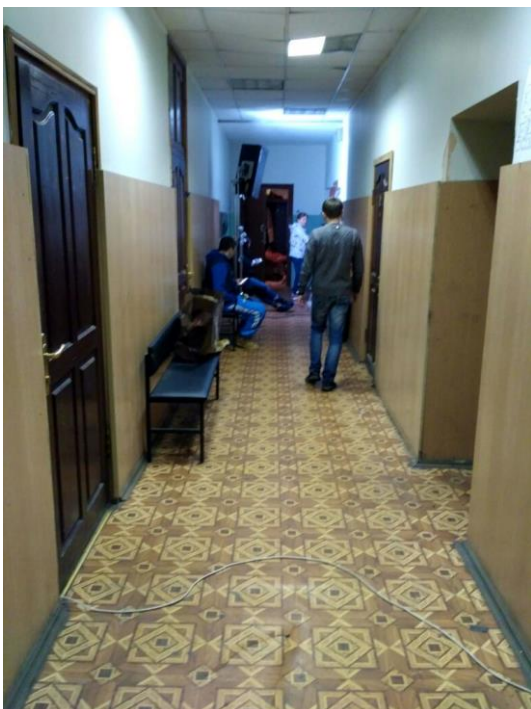
Фото 17. Состояние помещений - коридоры
