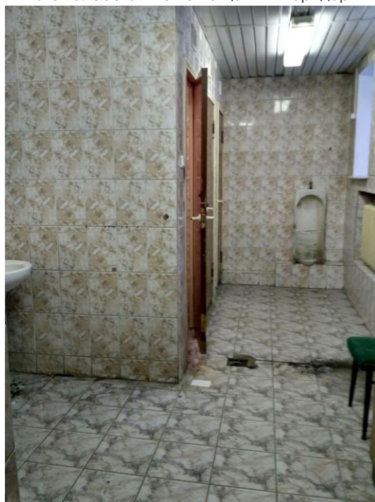
Фото 20. Состояние помещений - санузлы
