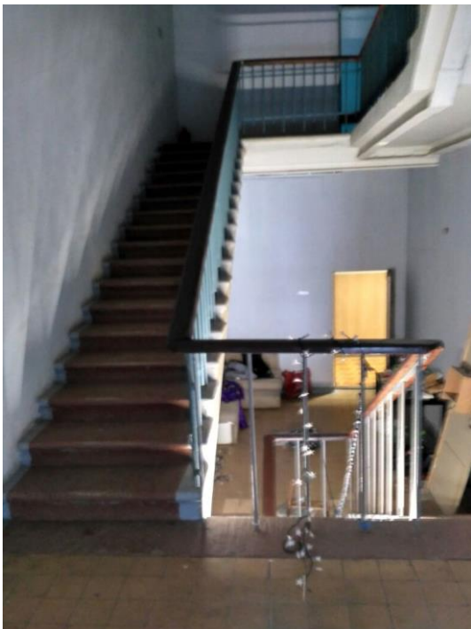
Фото 13. Состояние помещений - лестница
