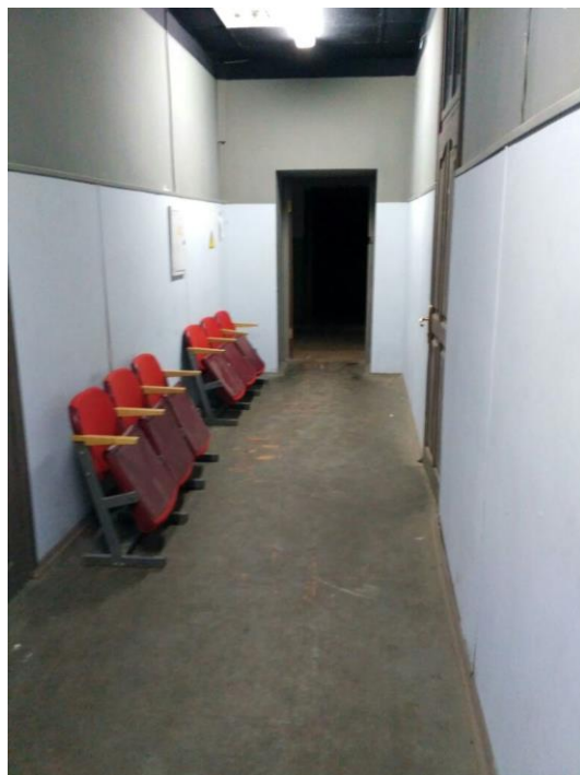
Фото 18. Состояние помещений - коридоры
