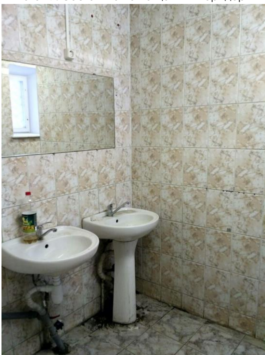
Фото 19. Состояние помещений - санузлы
