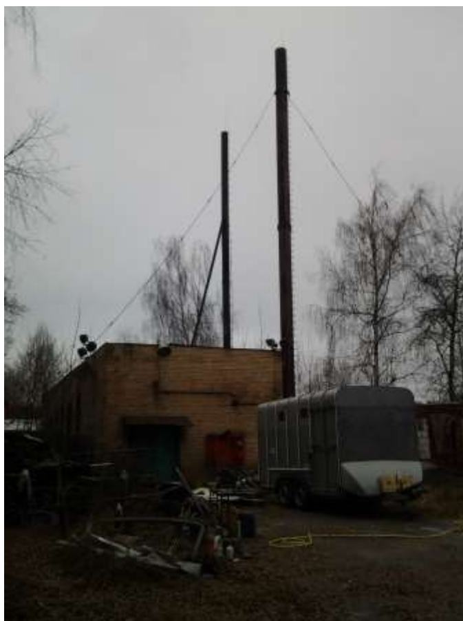
Ф 17 водонапорная + труба при въезде слева
