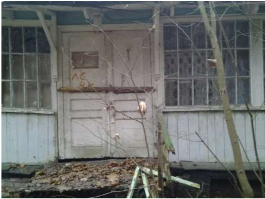
Ф 9 здание изолятора для взрослых
