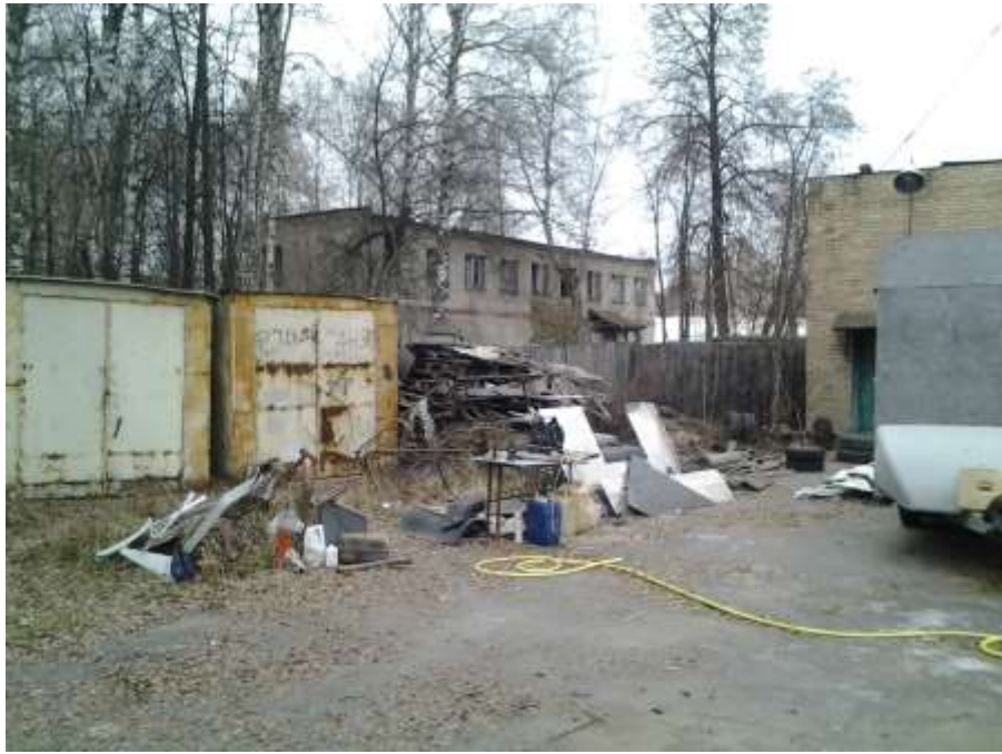
Ф 10.1 общий вид склад+ котельная справа
