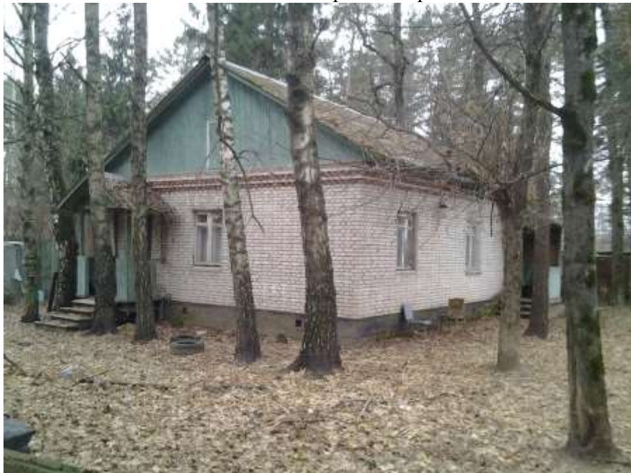
Ф 10 вид на склад + котельная справа
