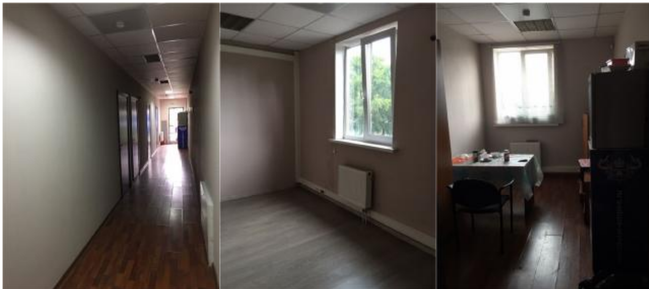
Фото 32-34. Внутренние помещения административно-офисного и бытового назначения.
