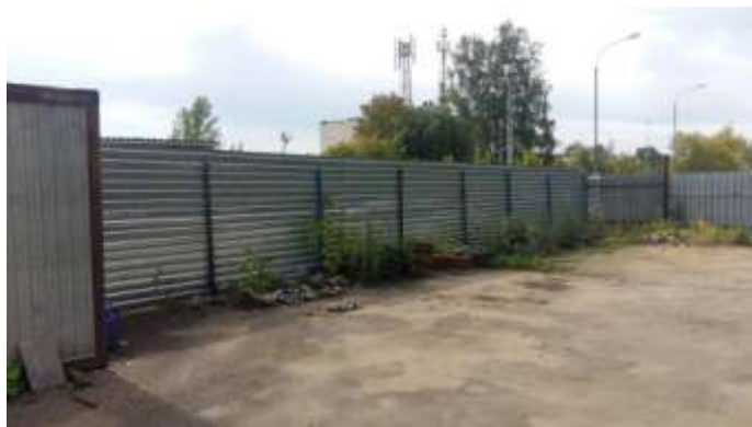
Въезд на огороженную площадку с въезда по ул. Базовская
