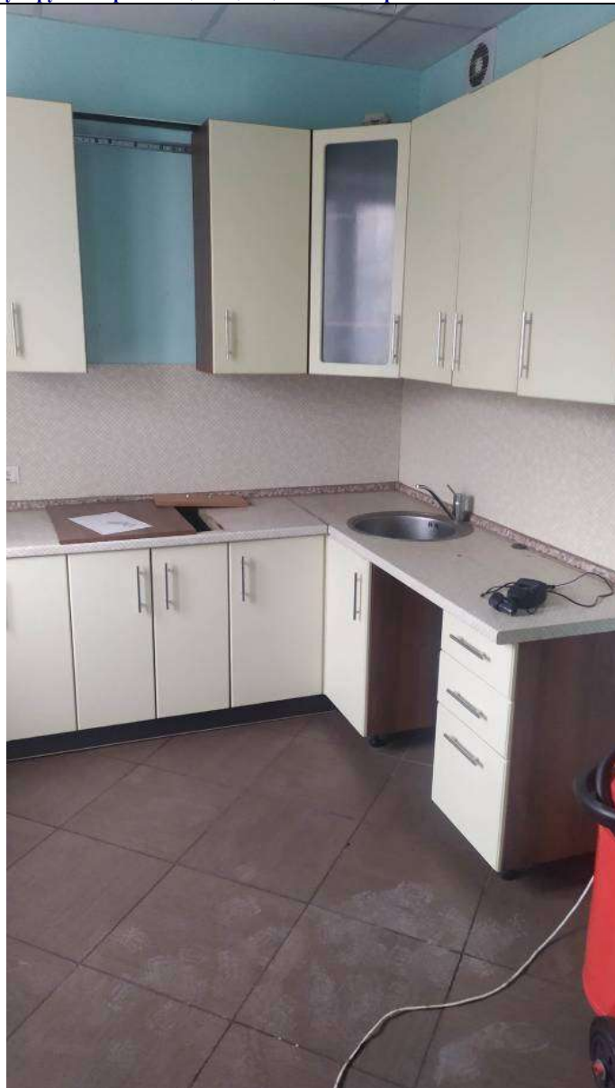
Помещение 7 вид справа
