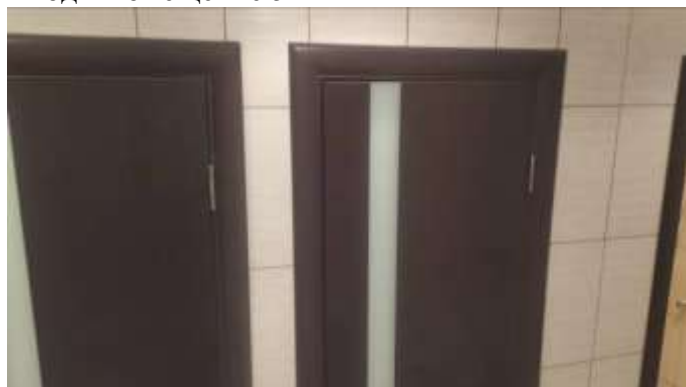
Помещение 5 вид слева
