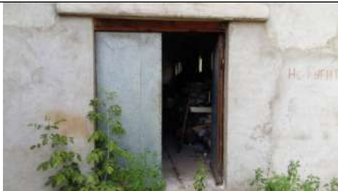
Вход в помещение первого этажа
