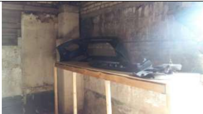
Вид справа от входа в складское помещение
