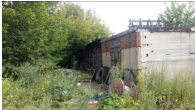
Вид слева от проезда по территории на складское помещение
