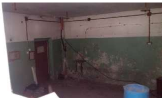
Вид смежного помещения на первом этаже
