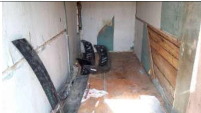
Вид складского помещения справа от вход
