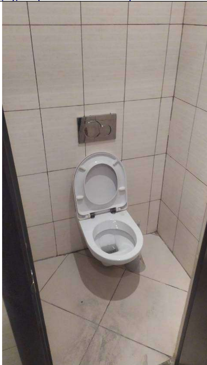
Помещение 5 вторая дверь от окна
