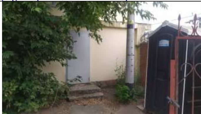
Вид справа от входных ворот (запасной выход из здания)
