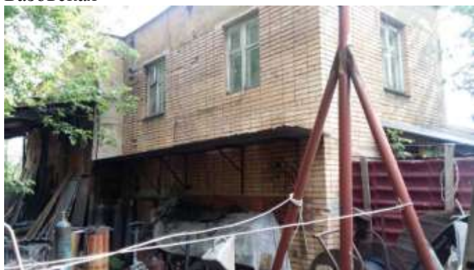
Административное здание вид сзади
