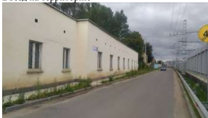
Сторона здания идущая вдоль дороги
