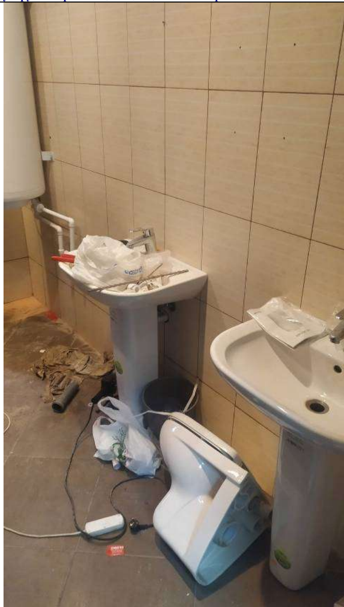
Помещение 6 вид справа
