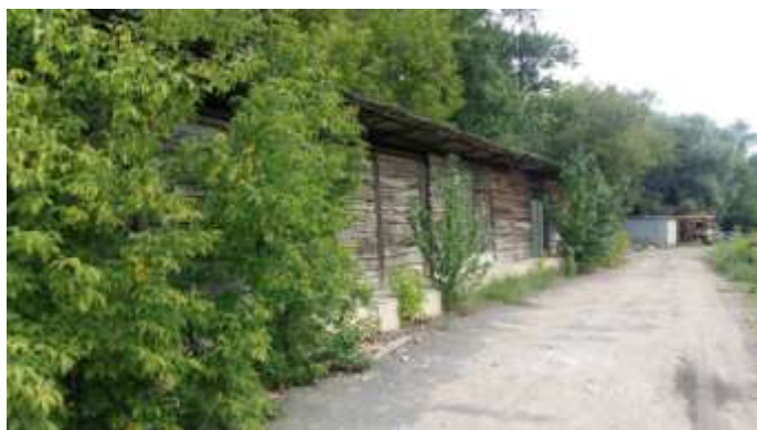
Вид на складские помещения (склады)
