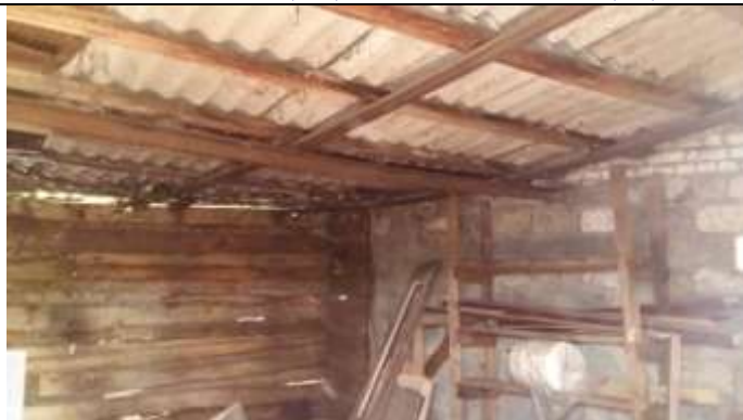
Вид помещения справа от входа
